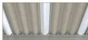
スチール折板(ベア付き)+FRP折板(1ヤマ) 組み合わせ例
